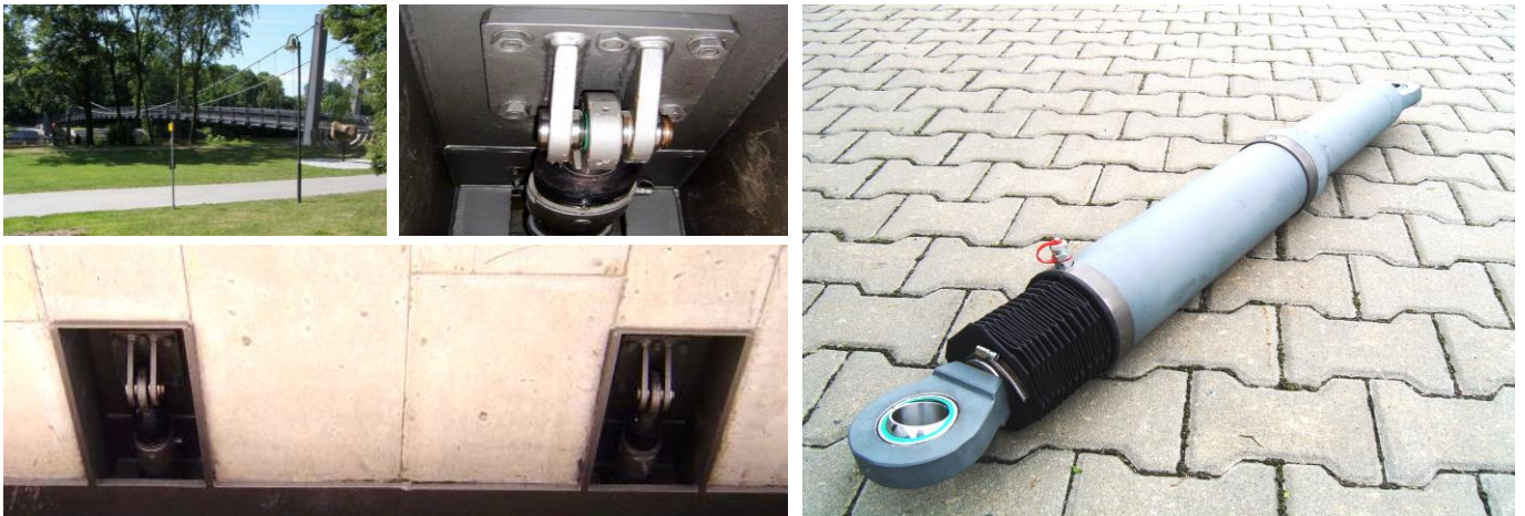
Hydraulický tlumič kmitů na lávce ke Strakonickému hradu
